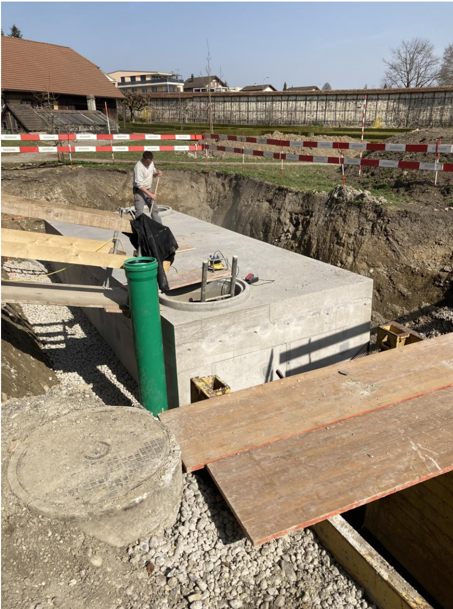
21.03.2022: Das Retentionsbecken ist fertig betoniert
